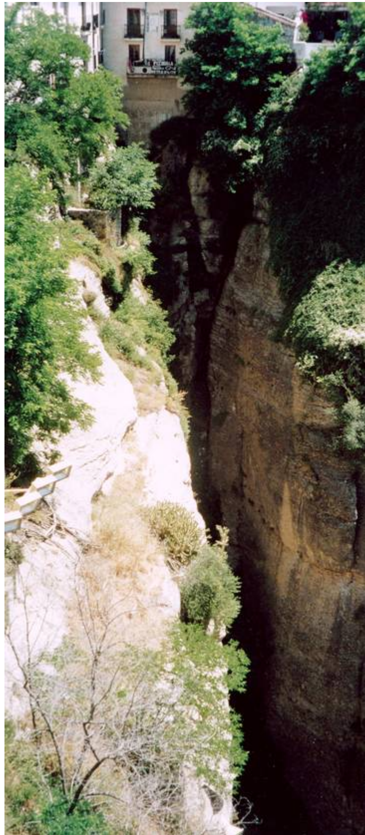
Blick auf die hängenden Häuser
